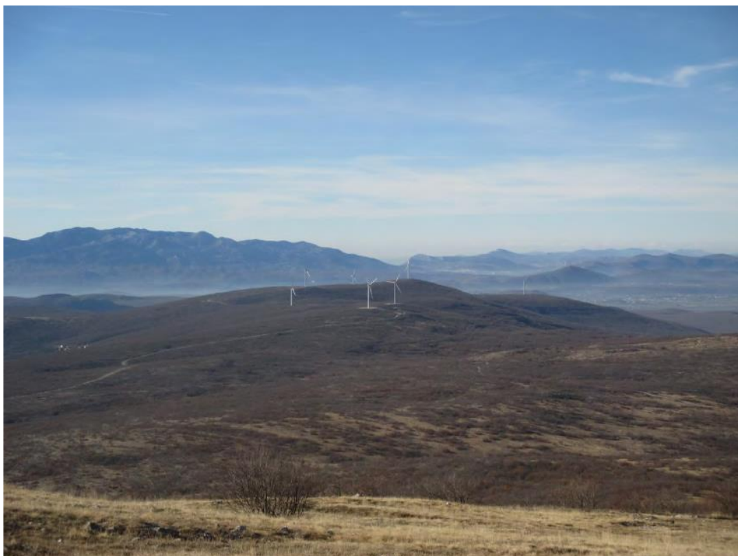
Slika 13. Vjetroelektrana ST 1-2 Kamensko
